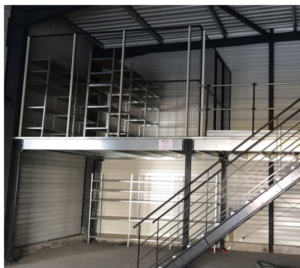
Délimitation du rayonnage Adaptiv XL par de la cloison industrielle, accessible sur une plate-forme Mezzaman Stock.
